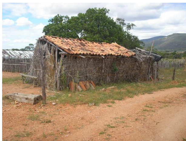
Figura 2 – Habitação Provisória em Projetos de Assentamento Recém-criados na Bahia, 2008.
