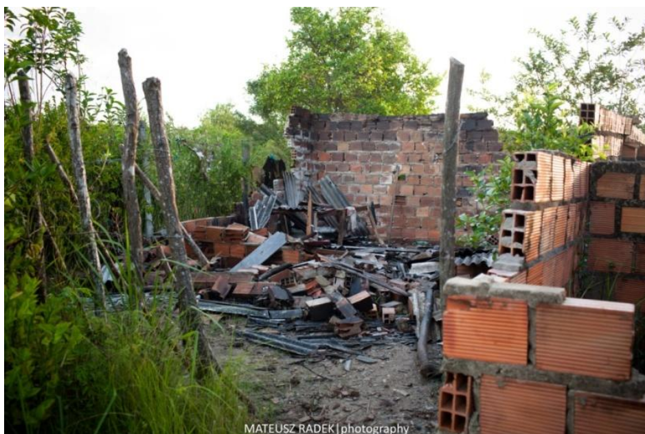
Foto 1 - Habitação que foi demolida.
